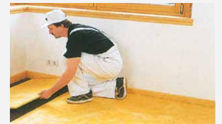
Trittschalldämmplatten mit einer dynamischen Steifigkeit von ca. 20 bis 40 MN/m 3 .
