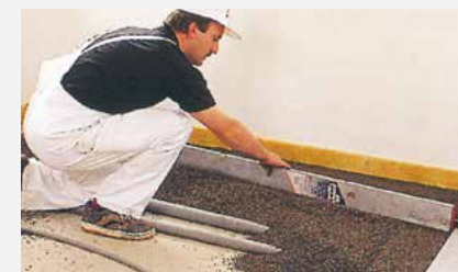
Liaporfitstreifen mit Waaglatte: in den Zwischenraum eingefülltes Liaporfit mit Waaglatte abziehen.
