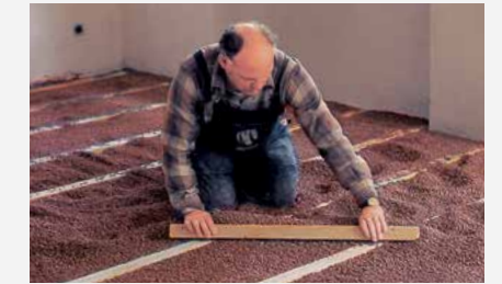
Liapor 4/8 bzw. Liapor 8/16 zwischen die Hilfskonstruktionen einfüllen und anschließend sauber abziehen.
