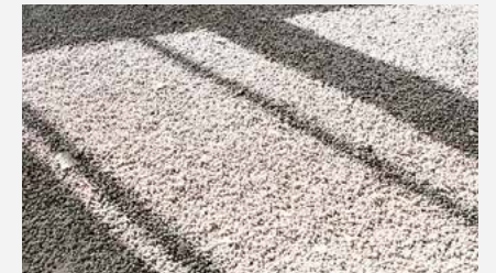
Vor dem weiteren Fußbodenaufbau ist auf eine ausreichende Austrocknung zu achten.
